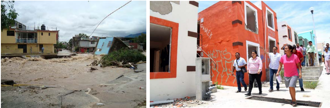
Figura 4 y 5: viviendas construidas para reubicación permanente en el Nuevo Mirador en la Ciudad de Chilpancingo, Guerrero, México, Fuente; https://suracapulco.mx/demoleran-el-viernes-edificios-para-damnificados-en-el-mirador-en-chilpancingo/
