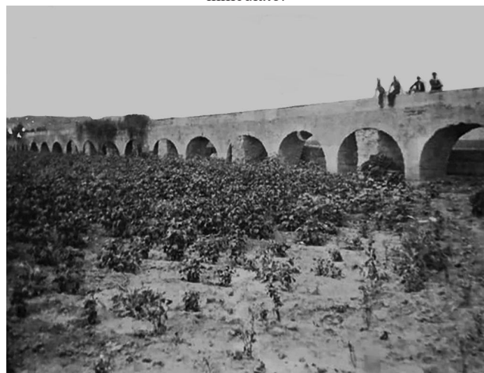
Figura 3: Acueducto en los años 20, cuando aún se observa la presencia de campos de cultivo en su entorno inmediato.
