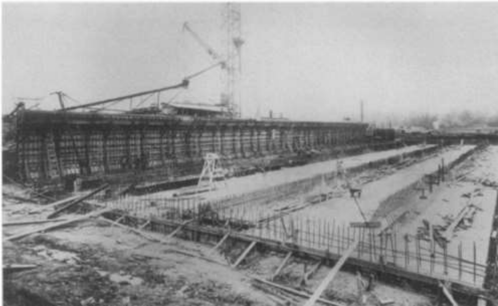
Figura 1. Construcción del primer sistema de lodos activados para la ciudad de Salford, Inglaterra. Fuente: Jones y Attwood, 1914.
