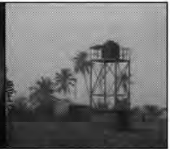
FOTO DE INFRA ESTRUCTURA DE AGUA Y SANEAMIENTO 4
