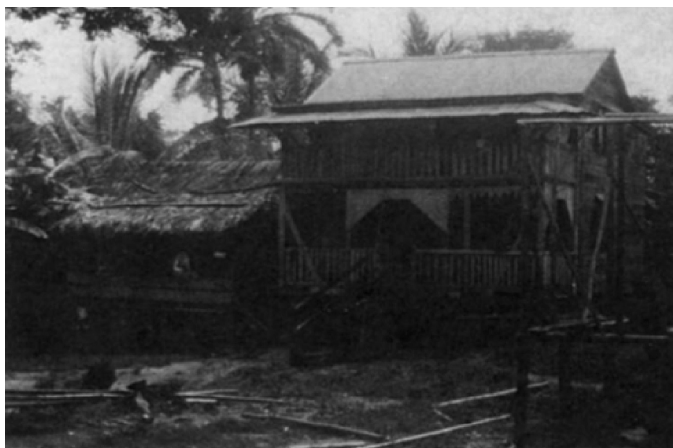
Fig. 4. Casa ulwa fabricada con una combinación de materiales de construcción tradicionales y modernos.
