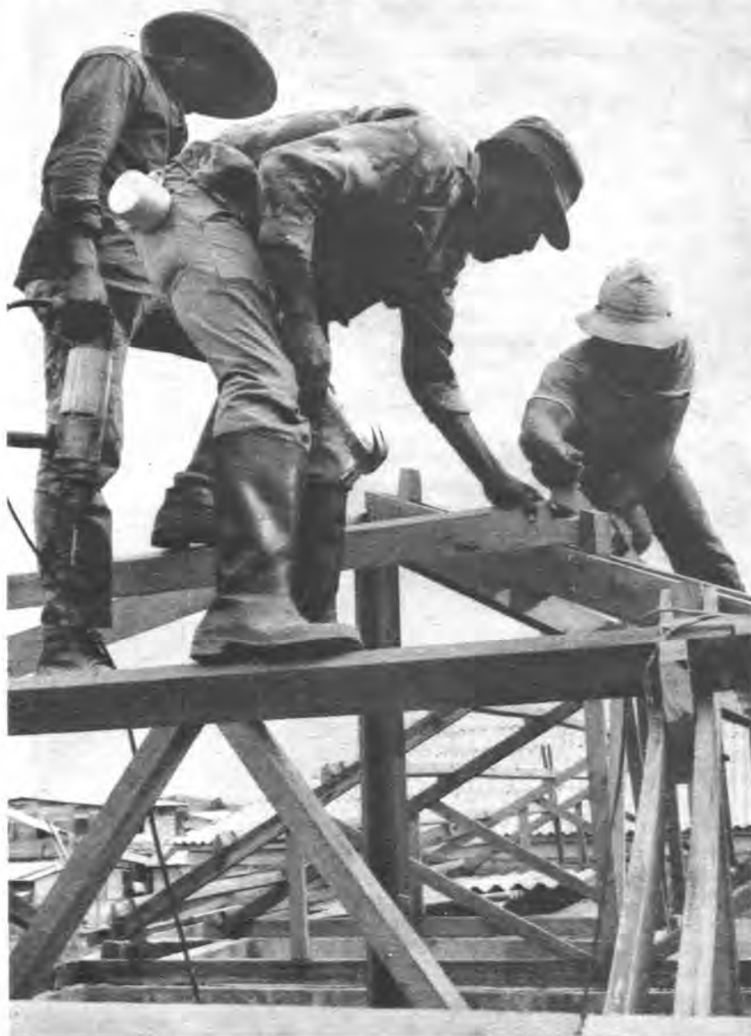
Brigadas de construcción, Bluefields, 1988.
