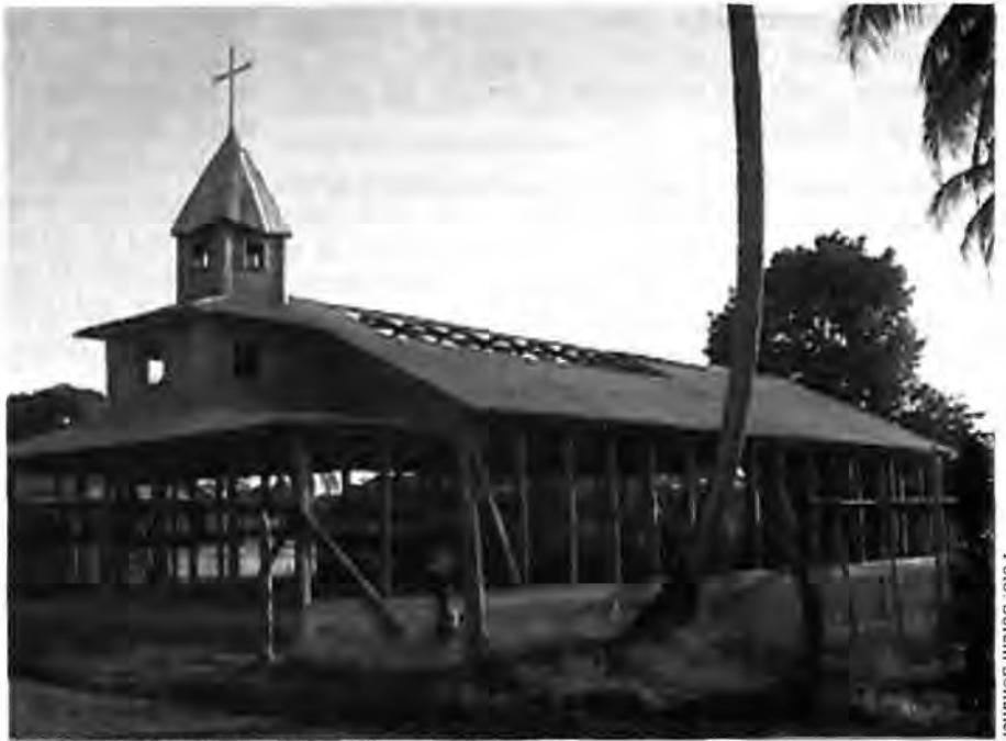
Construcción de la Iglesia Morava, Alamikangban, 1998.
